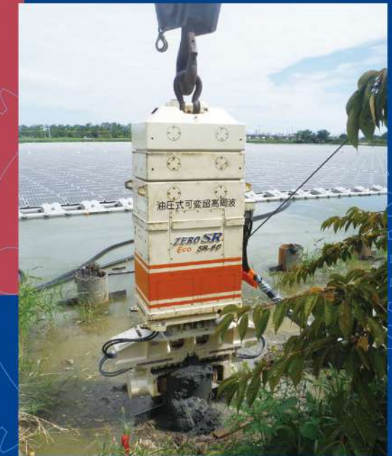
工事名: 岡山浦安水上メガソーラー発電所建設工事 杭規格: 鋼管杭Φ600(L=17.0m) 施工現場: 岡山県
