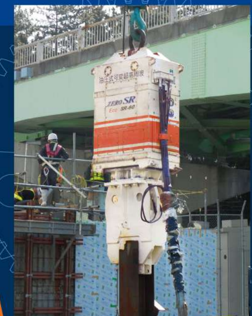
工事名: 和歌山下津港海岸(海南地区)等の浦水門取付護岸築造等工事 杭規格: 350H(L=36.5m) 発注: 国土交通省
