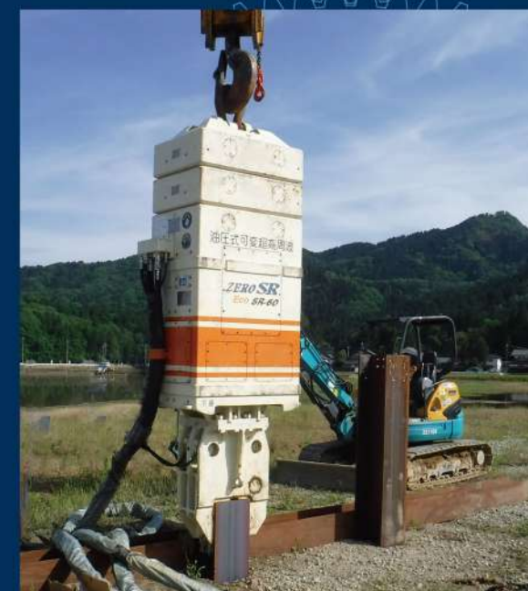
工事名: 北陸新幹線福井橋りょう他 杭規格: 350H(L=23.0m) 施工現場: 福井県福井市
